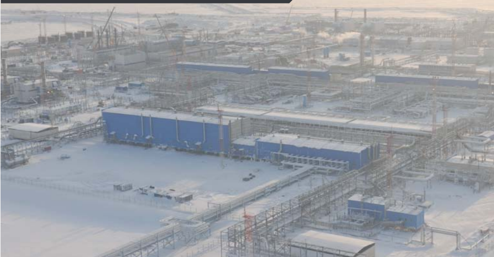
GAZPROMS STØRSTE nye gassfelt, Bovanenko, på Jamalhalvøya.
